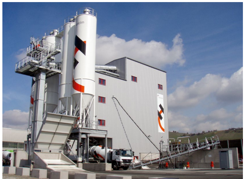
Das ausgezeichnete Transportbetonwerk der Holcim Kies und Beton GmbH im Stuttgarter Neckarhafen.
