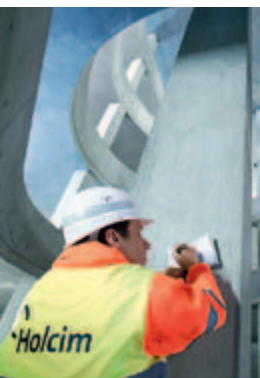
Im Bild eine anspruchsvolle Sichtbetonoberfläche im Parkhaus der Elbphilharmonie
