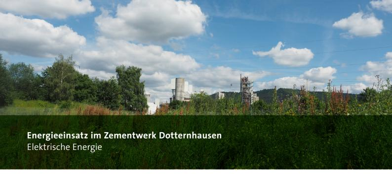
Die Herstellung von Zementen erfordert einen hohen Strombedarf. Maßgeblich dafür sind sehr große Antriebe, die aufgrund der großen Durchsatzmengen notwendig sind. Der Hautpstromverbrauch geht in die Klinker- und GÖS-Produktion mit deren Brecher, Mühlenantrieben, Ofenantrieben und Gebläsen. Auch die Zementmahlung mit ihren großen Mühlenantrieben, Gebläse und Sichter haben einen erheblichen Stromverbrauch.
