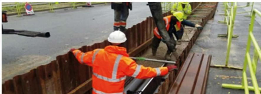
**Holcim Thermaflow** ist in verschiedenen Festigkeiten (aushubfähig oder nicht aushubfähig) sowie in unterschiedlichen Wärmeleitfähigkeitswerten  $W/(m \cdot K)$  verfügbar.
