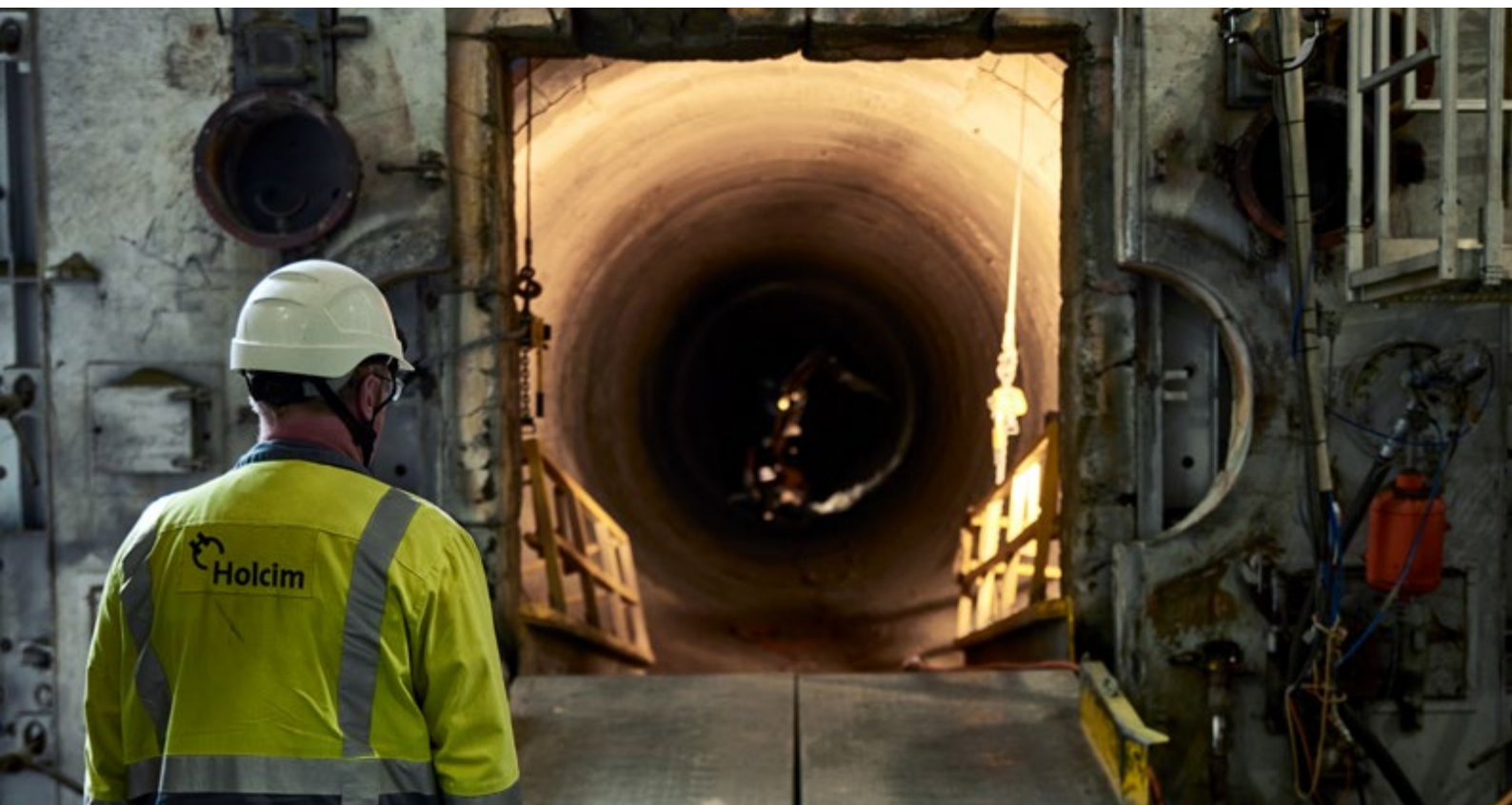
Stehender Drehofen bei Reparaturarbeiten.
