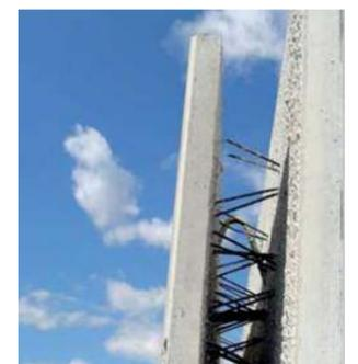
Abb. 7.1.7 Elementwände mit Ortbetonergänzung
