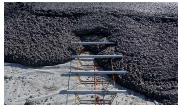
Abb. 8.4.19 Verdübelung durch Dübeleinlagekorb beim Betonieren
