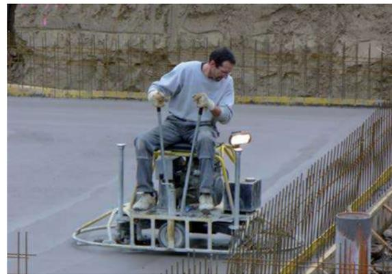
Abb. 8.14.2 Maschinelles Glätten einer Bodenplatte mit dem Flügelglätter - Handglätter
