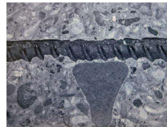
Abb. 3.4.2 Abstandhalter sorgt für ausreichende Betondeckung
