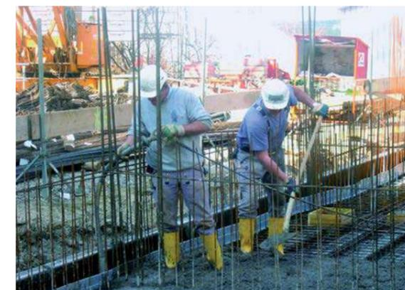
Abb. 5.1.6 Verdichten von Frischbeton
