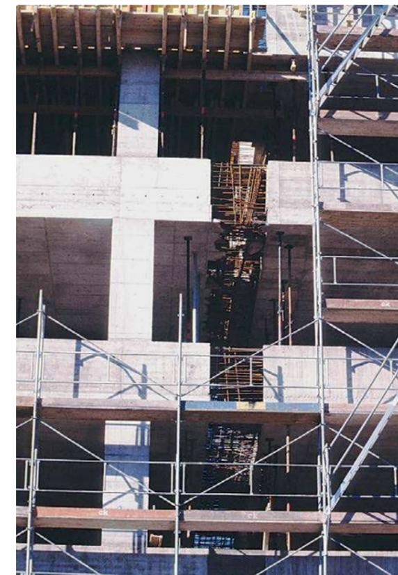
Abb. 10.3.2 Schwindgasse bei einem großen Gebäude
