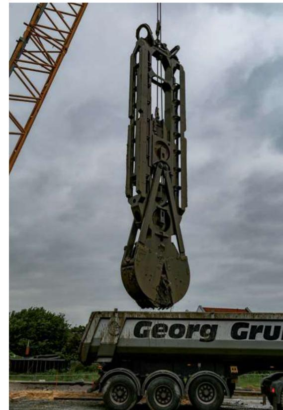
Abb. 8.9.1 (links) Ausheben einer Schlitzwand
