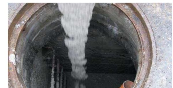
Abb. 7.6.15 Hohlraumverfüllung mit Porenleichtbeton
