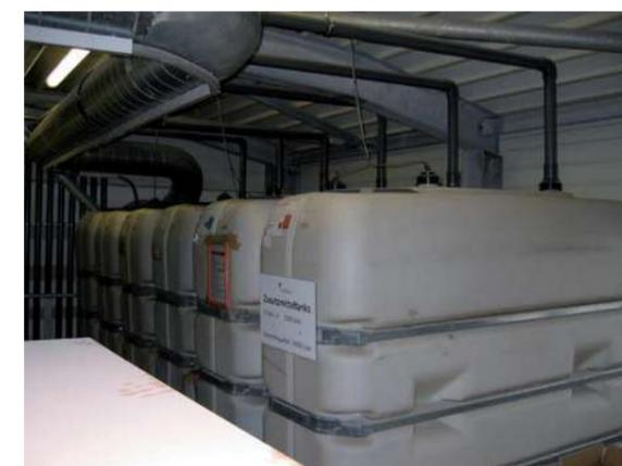
Abb. 1.5.7 Vorschriftsmäßiges Tanklager für Zusatzmittel in einem Transportbetonwerk
