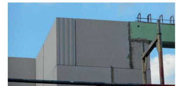
Abb. 7.6.16 Porenbetonsteine
