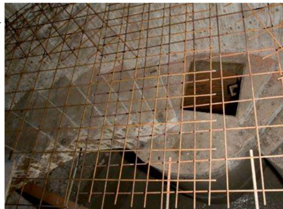
Abb. 8.17.9 (rechts) Hinterfüllung eines Schwimmbeckens
