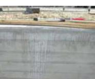
Abb. 10.2.4 bis 10.2.9 Diverse Ausblühungen an Betonoberflächen
