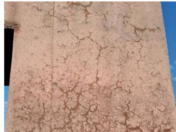
Abb. 10.7.12 (rechts) Betonbauteil mit starker Rissbildung infolge AKR
