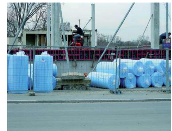
Abb. 5.3.12 Vorhalten von Wärmedämmmatten zur thermischen Nachbehandlung
