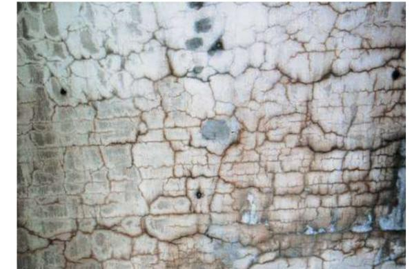
Abb. 10.7.14 Starke Rissbildung infolge Quellens des Betons, verursacht durch eine Alkali-Kieselsäure-Reaktion
