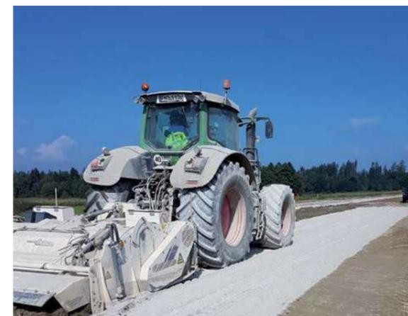
Abb. 8.18.3 Maschine beim Ausstreuen von Bodenverfestigungsmaterial
