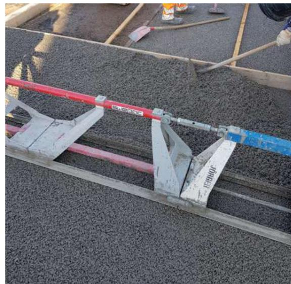
Abb. 7.11.1 Dränbeton beim Einbau, Abziehen mit der Rüttelbohle
