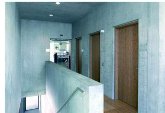
Abb. 8.3.3 Bürotrakt Leitstand Holcim (Süddeutschland) GmbH in Sichtbeton
