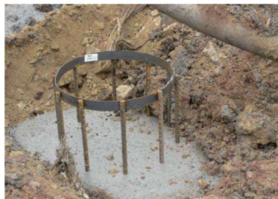
Abb. 8.8.10 (rechts u.) Große Baustelle bei der Erstellung von Bohrfählen
