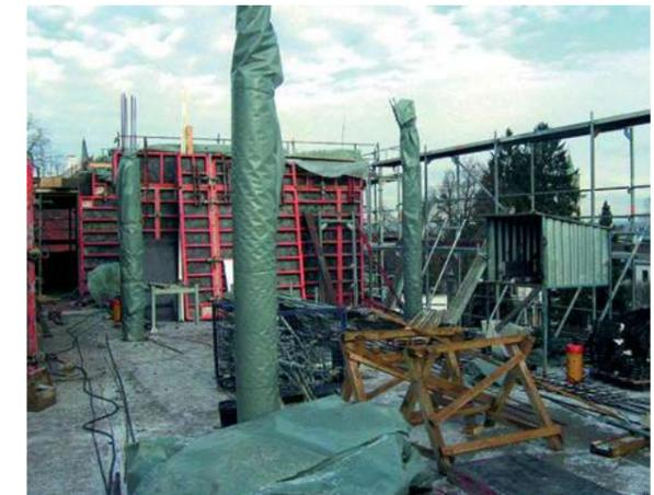
Abb. 5.3.11 Schutz des Betons vor Auskühlung durch belassen in der Schalung und Abdecken der Oberfläche mit Folien
