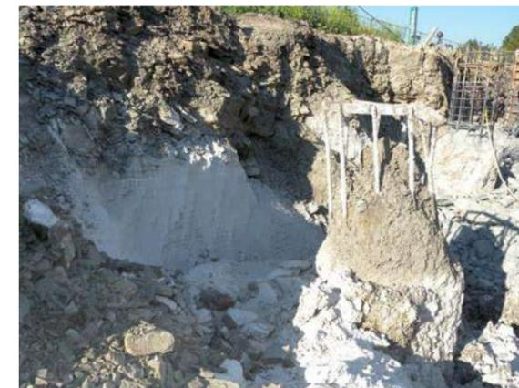
Abb. 10.6.3 Bohrfähle mit SR-Zement im gipshaltigen Boden
