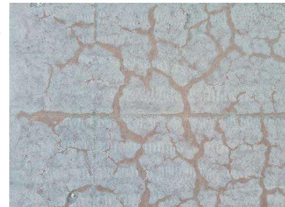
Abb. 10.7.11 (links) Rissbildung als Folge einer Alkali-Kieselsäure-Reaktion
