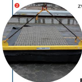
Für die Verlegung der Typen GS-VB und Typ Basalton® 15 cm wird gegen Kaution eine Traverse/ein Spreader samt der benötigten viersträngigen Kettengehänge zur Verfügung gestellt. Eine Verlegeanleitung ist auf Anfrage erhältlich.
