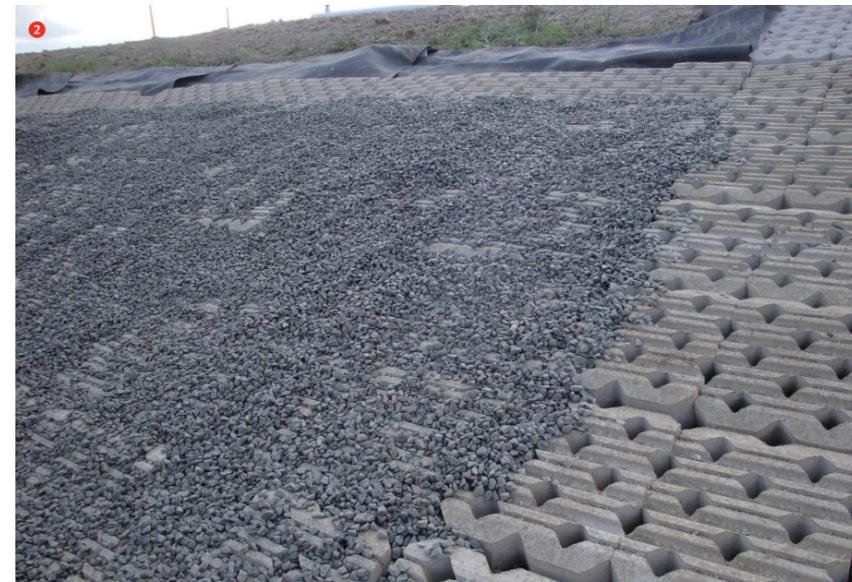
Die Wasserdurchlässigkeit des Geotextils verhindert die Entstehung eines Überdrucks, während die Dichtheit des Geotextils einer Erosion des Untergrunds vorbeugt. Die Betomat kann mit gebrochenem Naturstein, beispielsweise Basalt, oder mit Pflanzsubstrat oder Mutterboden abgedeckt werden. ❷
