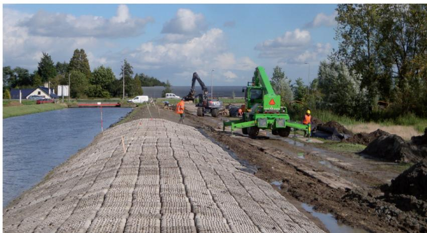
Im modernen Uferbau werden im Interesse des Flora- und Faunaschutzes flach abfallende Böschungen bevorzugt. Da hierfür nicht immer genügend Raum zur Verfügung steht, werden Ufer mit einer Schrägböschung oder Berme realisiert. ❶
