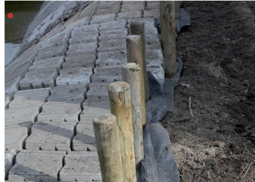
Die Betomat wird mit zwei- oder dreiseitiger Überlappung aus Geotextil geliefert. Bei der Verlegung wird die Matte auf der Überlappung der vorhergehenden Matte angebracht, wodurch einer Auswaschung des Bodens vorgebeugt wird. **Auf steilen Böschungen können die Matten erforderlichenfalls an der Oberkante mit Rundholzpfählen befestigt werden.** ❶
