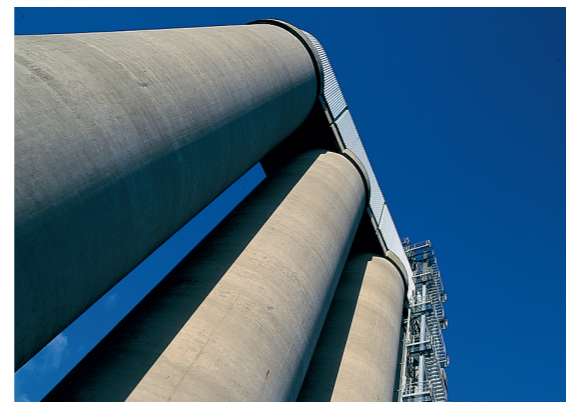
In Silos wird der fertige Zement bis zum Versand zwischengelagert
