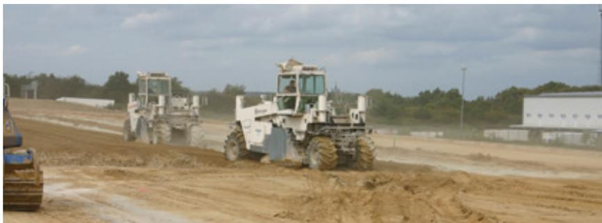
**WICHTIGER HINWEIS:** Bei Boden- und Lufttemperaturen unter +5°C sollten möglichst keine qualifizierten Bodenverbesserungen ausgeführt werden!
