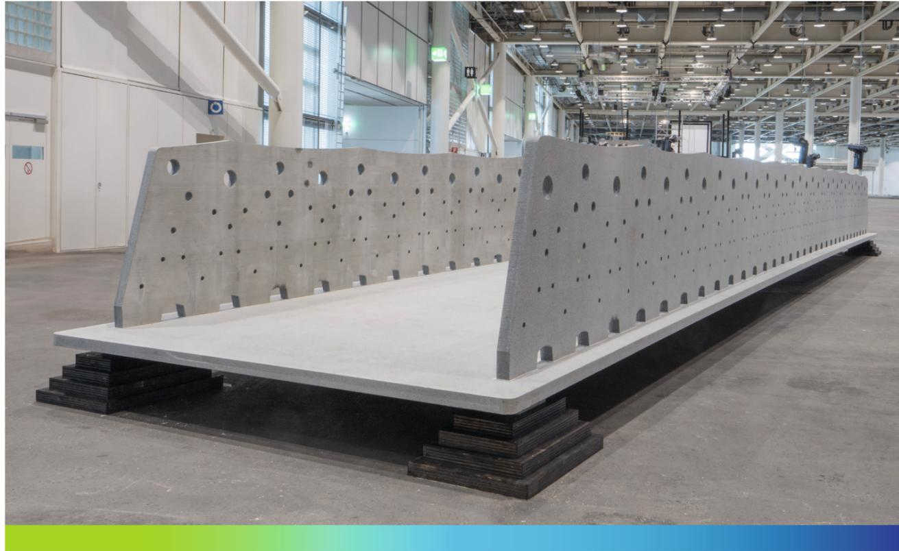
Durch die filigrane Bauweise der Modulbrücken wird das Durchflussprofil nur minimal beeinträchtigt. Durch die Vorfertigung verringert sich zudem die Einbauzeit stark.
