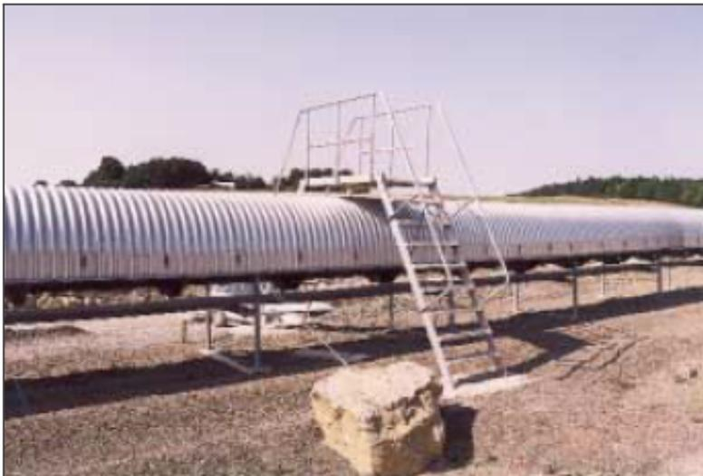
Bild 19 Beispiel sicher zu überqueren durch Laufsteg
