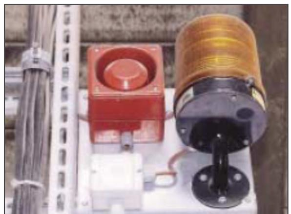
Bild 30 Beispiel einer akustischen und optischen Anlaufwarneinrichtungen
