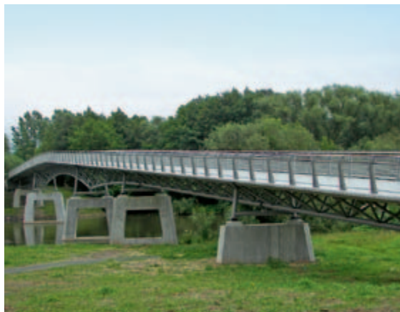
Gärtnerplatzbrücke Kassel (Bild: Universität Kassel)
