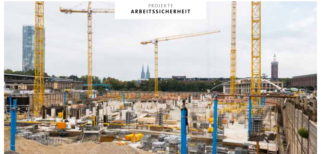
Mitten in Köln – Das Großprojekt MesseCity im Stadtteil Deutz stellt hohe Anforderungen an Sicherheit und Logistik.
