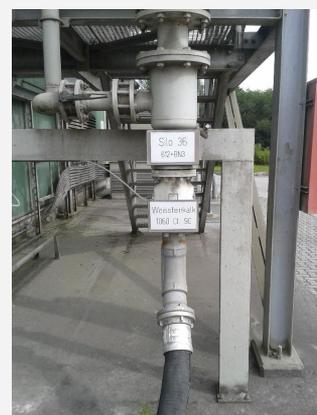
**Sicherungsschellen oder Tankwagenkupplung benutzen !**
