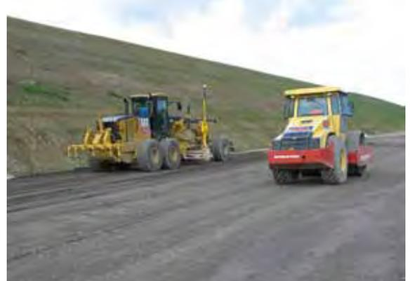
*Einbau einer hydraulisch gebundenen Tragschicht unter Verwendung von pechhaltigem Ausbaustoffen auf der BAB A 81. Der Einbau erfolgte mittels Grader.*
