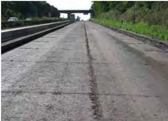
*Längs- und Querfugen unter einer späteren Asphaltdecke auf der BAB A 8*
