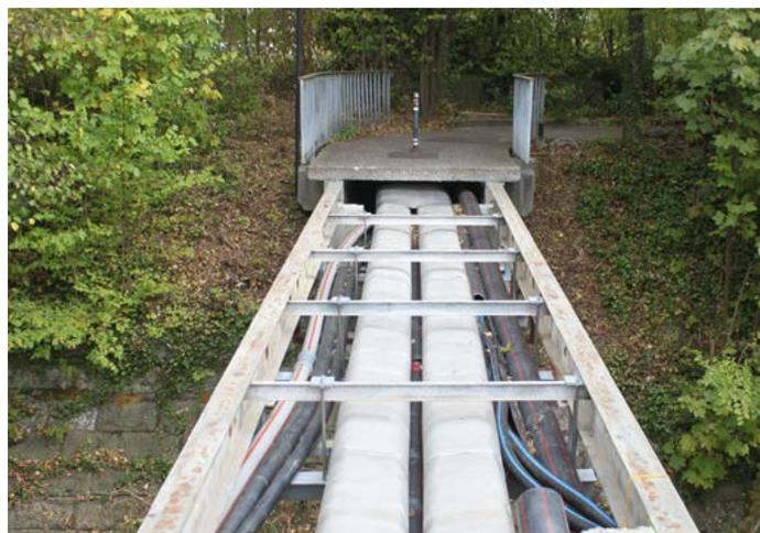
Dies entspricht einer leichten Stahlbrücke. Eine vergleichbare konventionelle Betonbrücke hätte ein Gewicht von ca. 750 kg pro m<sup>2</sup>, wäre also rund 4 mal schwerer und würde dadurch auch die Auflager wesentlich stärker belasten. Auch dies ein wesentlicher Vorteil des neuen Konstruktionsprinzipes
