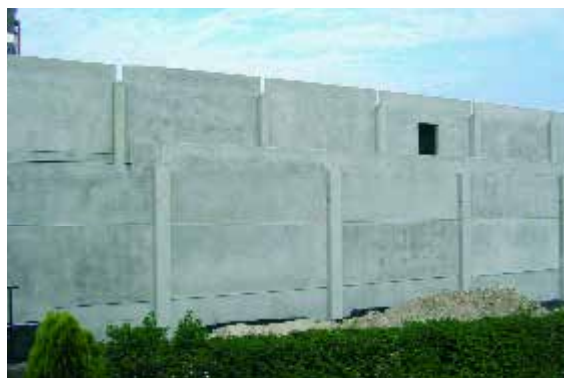
Abb. 2.8 Unterschiedliche Farbwirkung der Elemente
