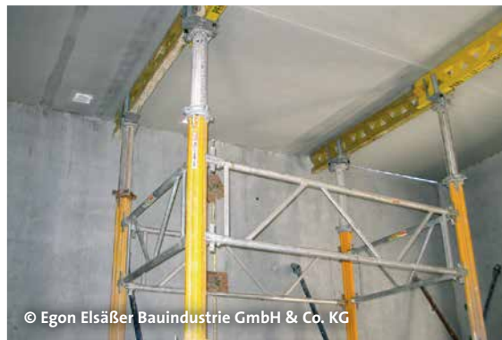
Abb. 11.2 Unterjochung einer Filigrandecke
