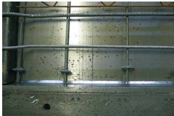
Abb. 4.5 Rost auf Stahltischen
