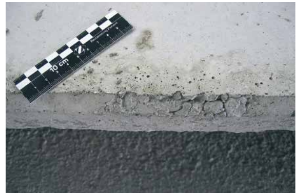
Abb. 2.2 Ausgelaufene Kante
