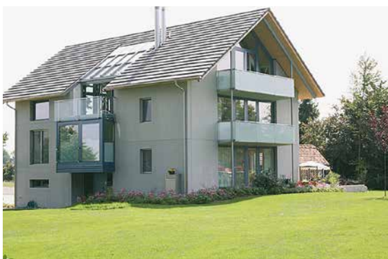
Abb. 6.20 Wohnhaus, Fassade mit Lasur überzogen
