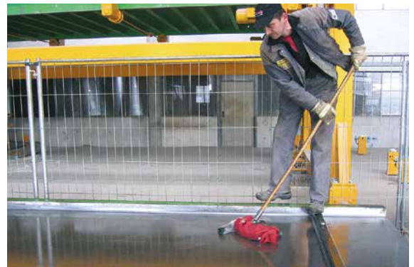
Abb. 4.2 Gleichmäßiges Verteilen mit Lappenhergestellt
