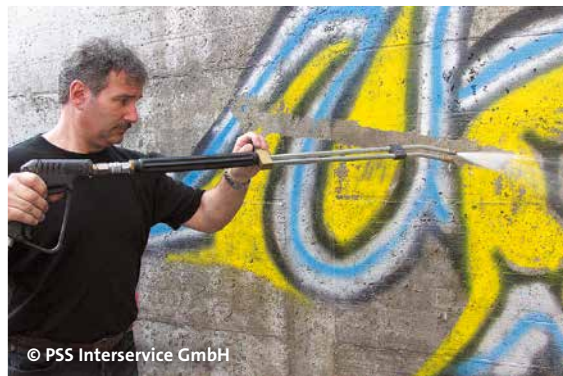
Abb. 6.22 Leichter Abtrag dank Graffitischutz
