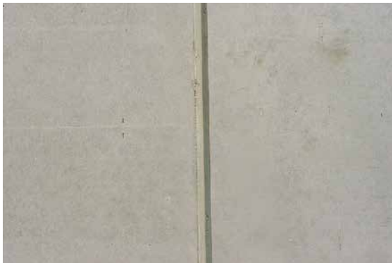
Abb. 2.1 Stoßfuge zwischen zwei Elementwänden
