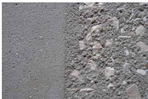
Abb. 6.7 Sandgestrahlte Oberfläche
