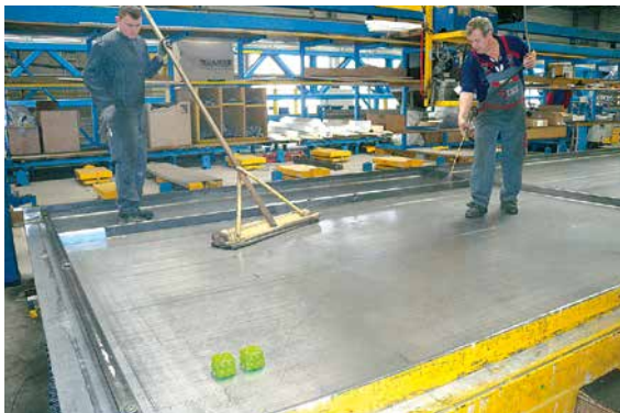
Abb. 4.1 Aufsprühen von Trennmittel
