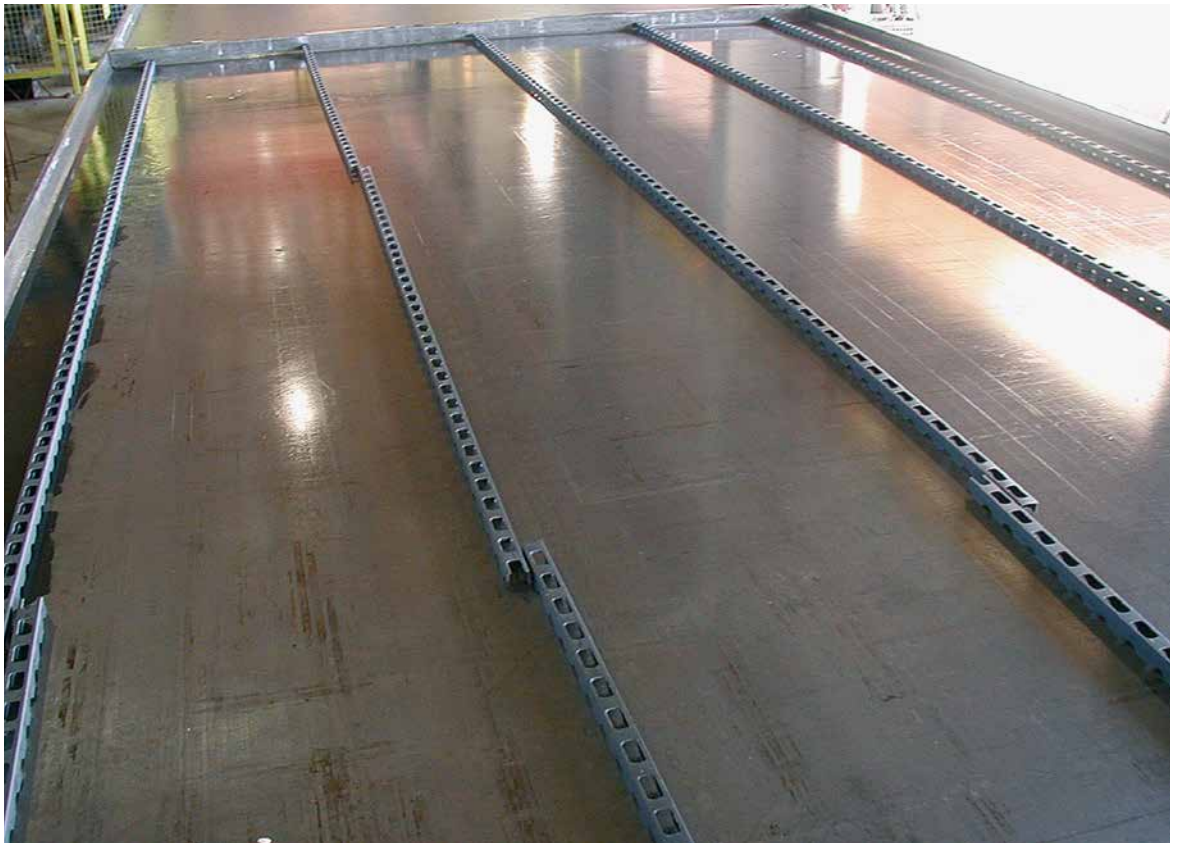
Abb. 3.1 Glatte, nichtsaugende Stahlschalung
