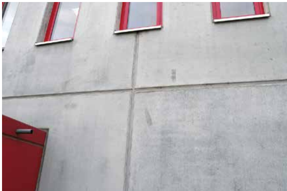
Abb. 2.6 Farbunterschiede zwischen den Elementen
