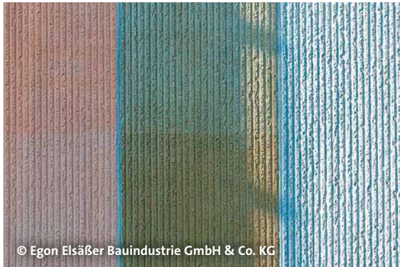
Abb. 6.17 Farbmuster, Lasuren auf grauer Betonoberfläche
