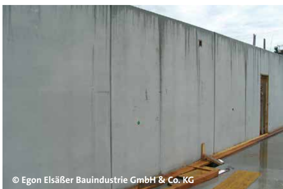
Abb. 1.5 Referenzfläche am bestehenden Objekt
