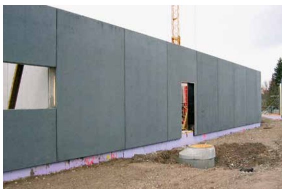
Abb. 6.14 Schwarz eingefärbter Beton am Beispiel der Stadthalle Rottweil
