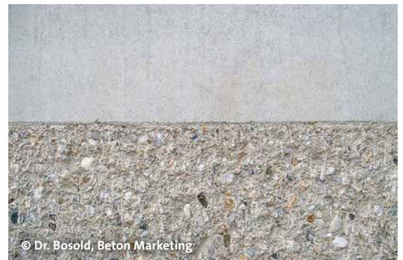
Abb. 6.10 Stocken einer Oberfläche
