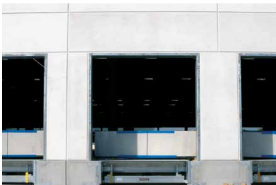
Abb. 2.3 Stoß- und Lagerfugen an einer Fassade
