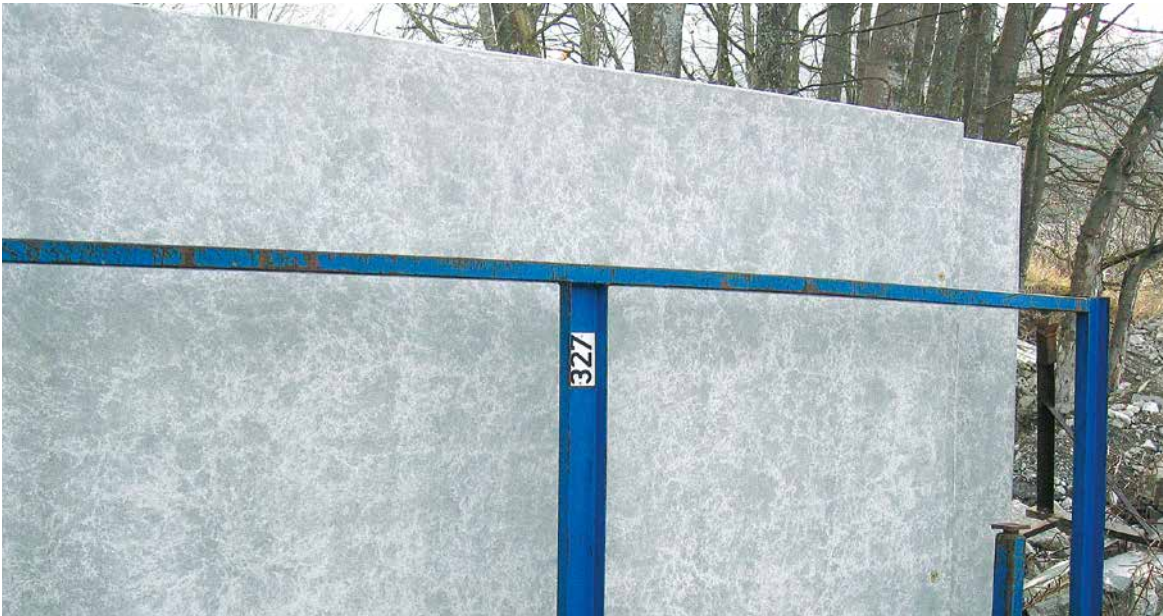
Abb. 3.2 „Lebendiger“ Beton durch Entmischung
