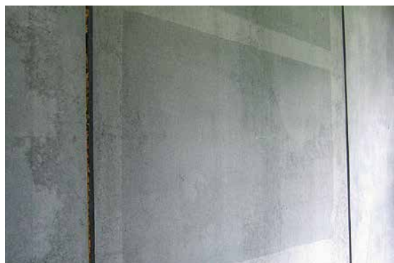
Abb. 5.6 Lagerungsbedingte Farbunterschiede
