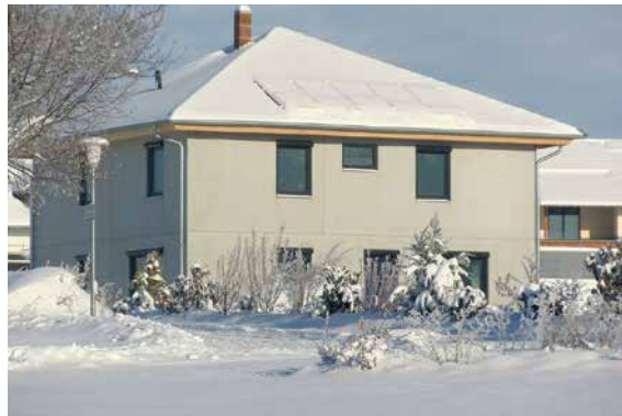
Abb. 10.2 Angemessener Betrachtungsabstand für ein Gebäude
