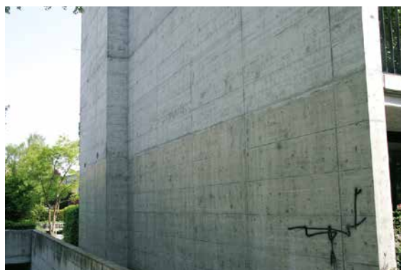
Abb. 6.23 Der Graffitischutz wirkt sich auf die Farbe der Betonoberfläche aus
