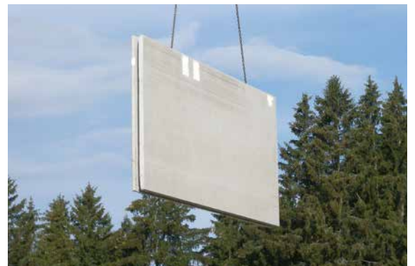
Abb. 7.2 Fertigteil am Kran
