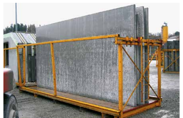
Abb. 9.4 Wasserschlieren führen zu Ausblühungen
