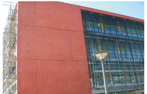
Abb. 6.19 Dieselbe Fassade, mit pigmentierter Lasur behandelt
