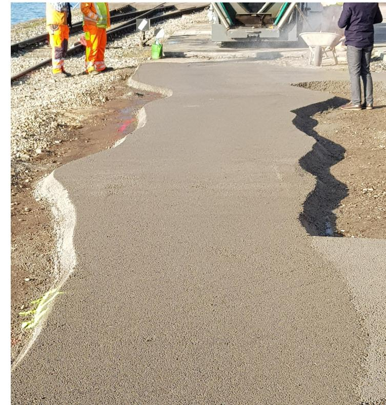
Entsprechend der örtlichen Gegebenheiten und Anforderungen an CampoDrain ist die Herstellung einer Deck- bzw. Tragschicht ab 12 bzw. 15 cm möglich.
