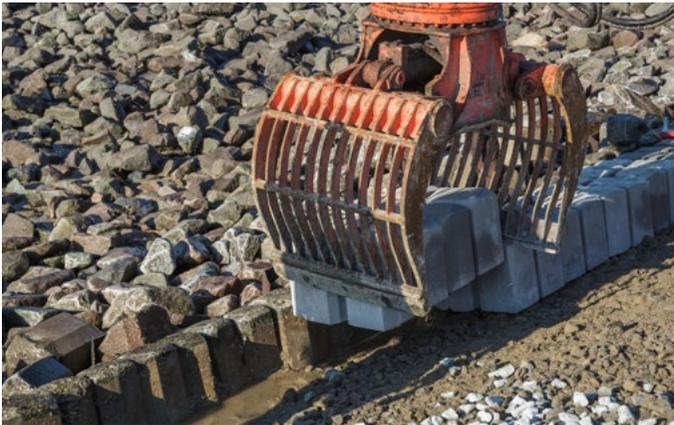
Holcim Basalton® Steinsetzung mit spezieller mechanischer Klammer
