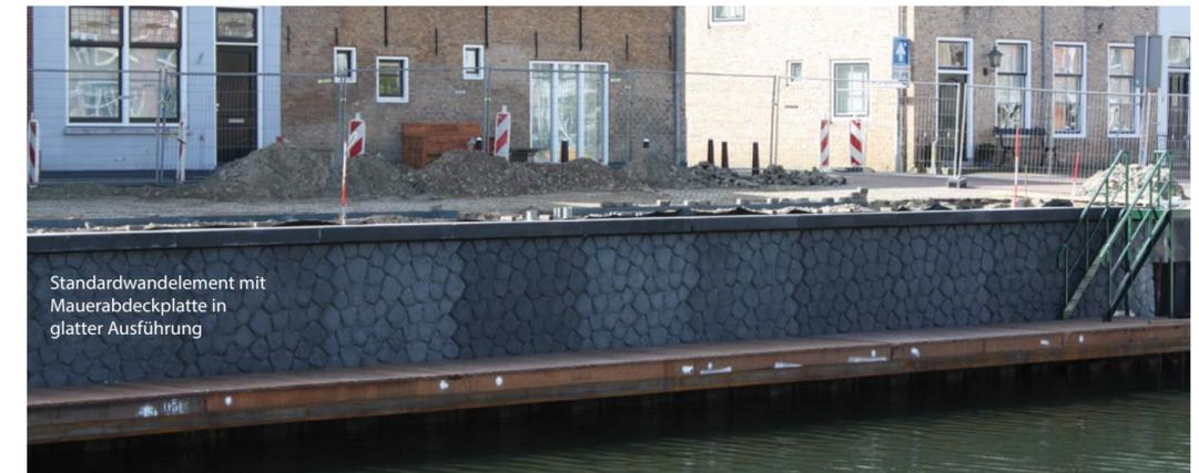
Standardwandelement mit Mauerabdeckplatte in glatter Ausführung
