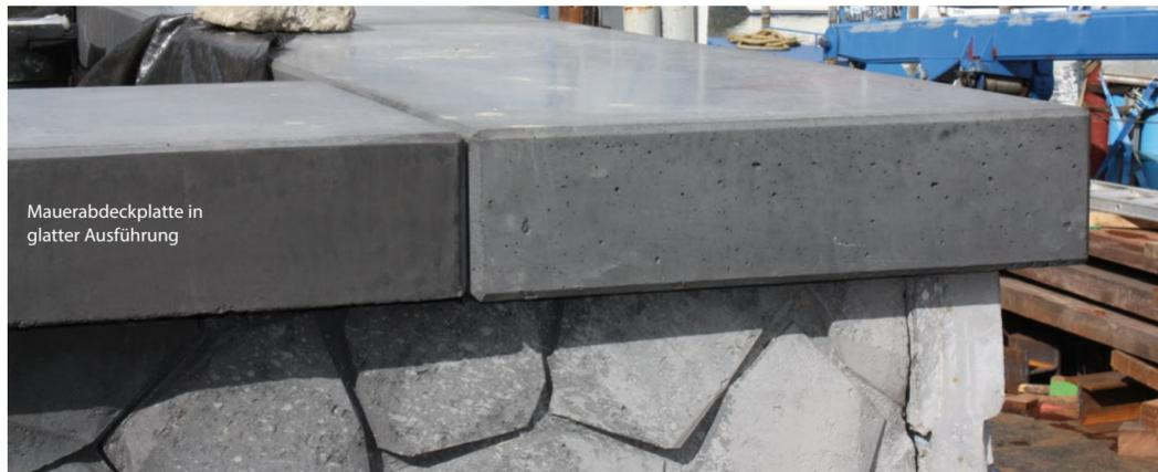
Mauerabdeckplatte in glatter Ausführung
