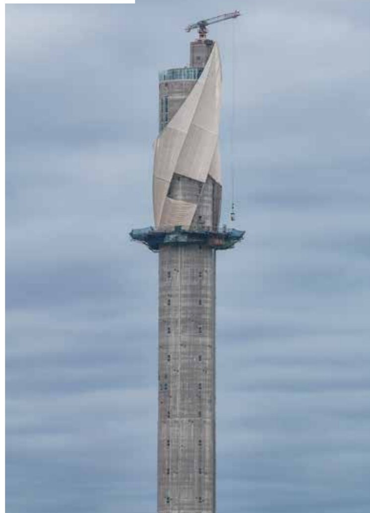
Filigran – In dem ThyssenKrupp Testturm in Rottweil steckt Zement von Holcim und dahinter der Entwurf von Werner Sobek und Helmut Jahn. Der Betonschaft ist mit einer Stoffhülle aus Glasfasergewebe verkleidet.
