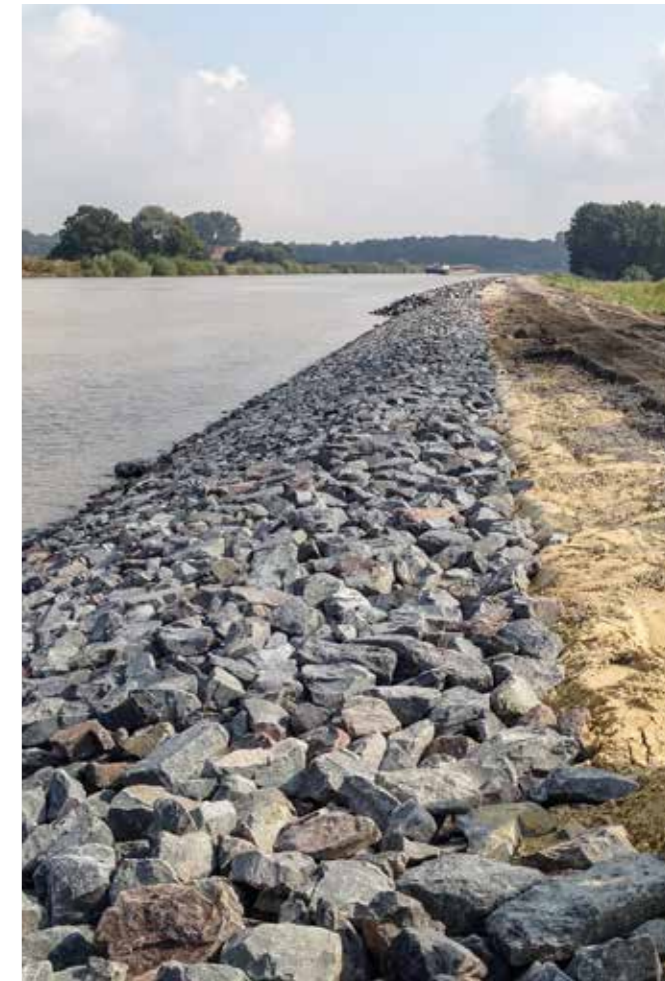
Dortmund-Ems-Kanal – Die Planungsarbeit war immens: aufgrund der komplexen Lieferkette und der überdurchschnittlich großen Liefermenge (507.000 Tonnen).
