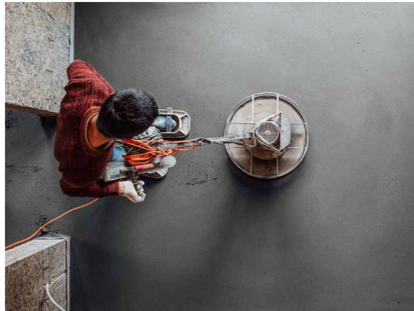
Eingebaut – Nachdem der Estrichboden verlegt und abgezogen wurde, wird er schließlich geglättet.
