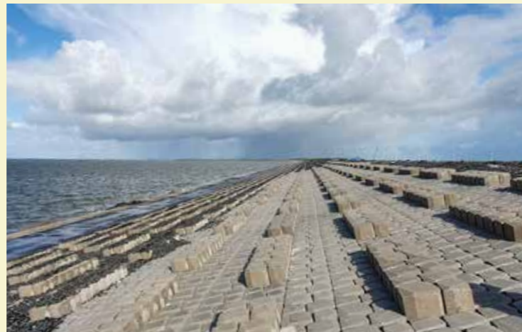
Nachhaltige Lösung – Bereits realisierter Abschnitt des Afsluitdijk mit Holcim Basalton Quattroblocks.
