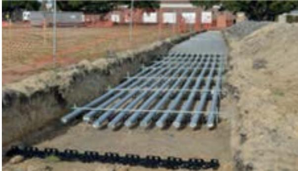
Unterirdische Verteiler und Leitungen zur Anbindung von Windparks und Rechenzentren an die (bestehende) Infrastruktur
