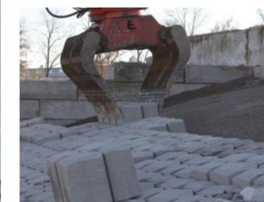
Der Basalton® Quattroblock wird ohne Paletten geliefert. Die Pakete wurden so entwickelt, dass die Sets mit einem handelsüblichen Sortiergreifer mit Adapterplatten abgeleget werden können.
