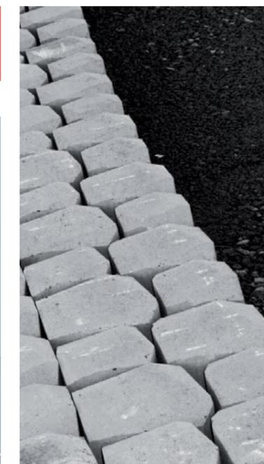
Das System ist so flexibel, dass die Basalton® Quattroblocks sowohl an geraden Hängen als auch in Kurven eine hohe Verlegeleistung bei geringeren Kosten ermöglichen.
