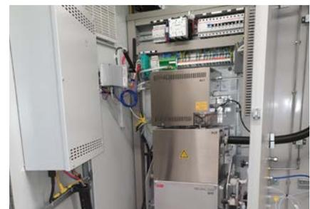
Der neue Messwertrechner (oben), Schalteinheit des neuen Messgerätes ACF5000 (unten)
