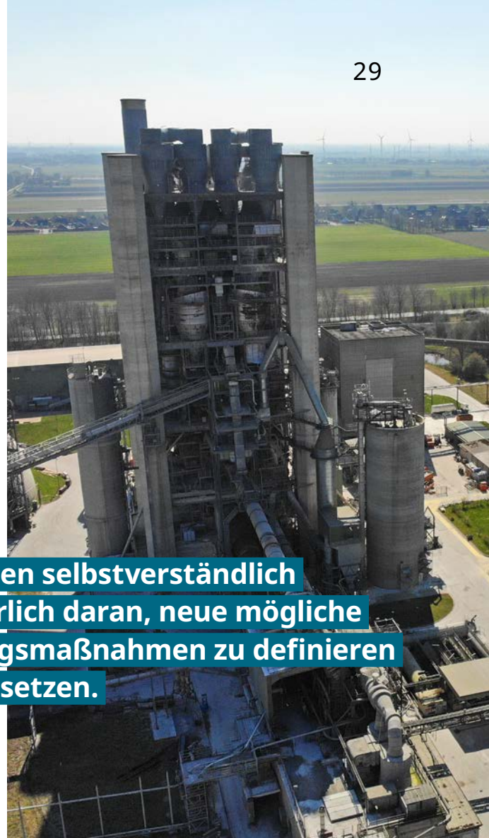
Drehofen mit Vorwärmerturm
