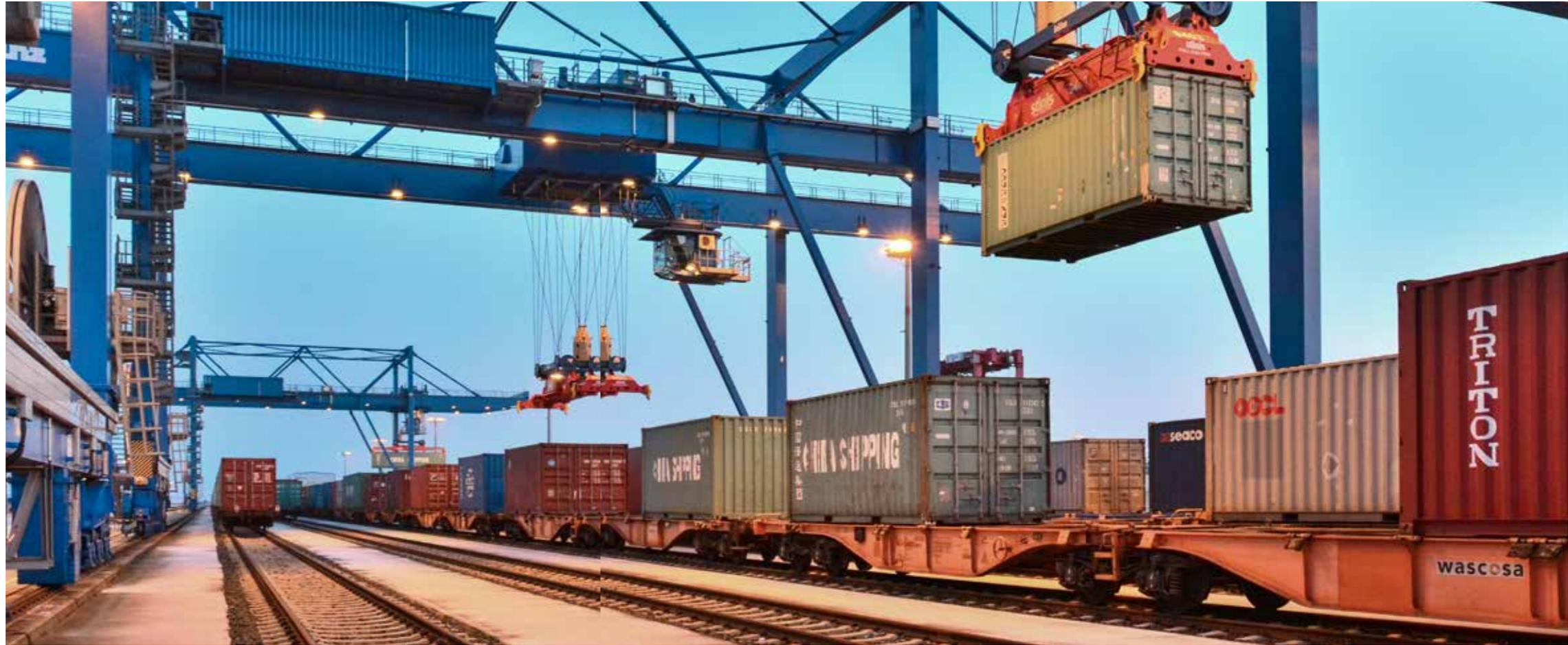
**Kombinierter Verkehr** – Vom Schiff auf die Schiene. Der sechsgleisige Terminal des JadeWeserPorts verfügt über fünf Portalkräne.
