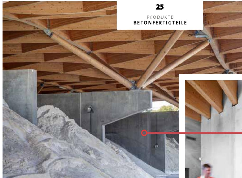
Holz auf Beton – Die Betonfertigteile von VETRA sind genau auf die Holzkonstruktion abgestimmt.
