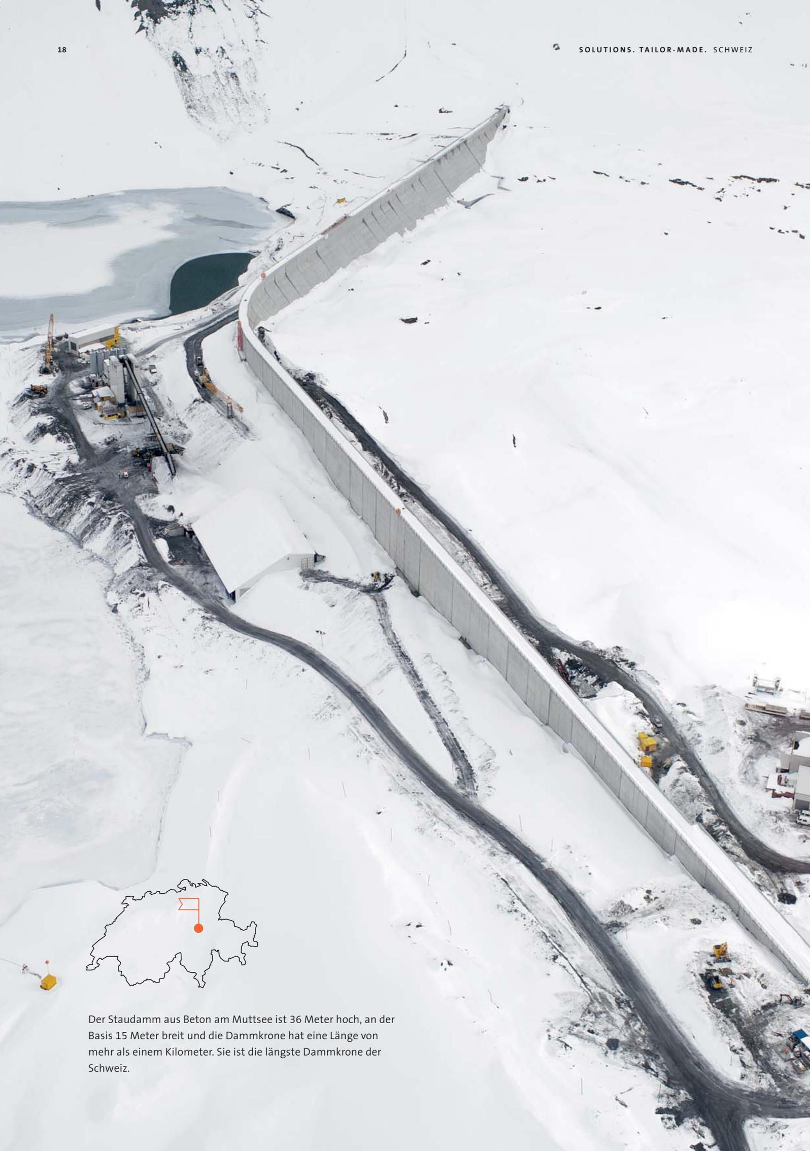
Der Staudamm aus Beton am Muttsee ist 36 Meter hoch, an der Basis 15 Meter breit und die Dammkrone hat eine Länge von mehr als einem Kilometer. Sie ist die längste Dammkrone der Schweiz.
