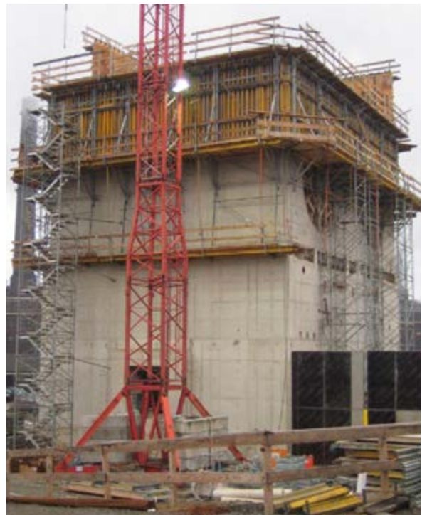
Besonders widerstandsfähig: Kühlturm aus Beton mit Holcim-Aqua 80
