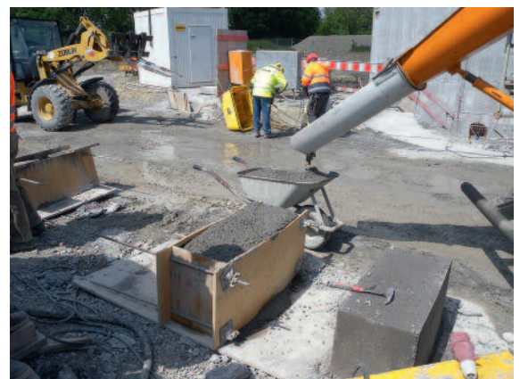
Auf der Baustelle wurden laufend Probekörper aus dem gelieferten Beton hergestellt.
