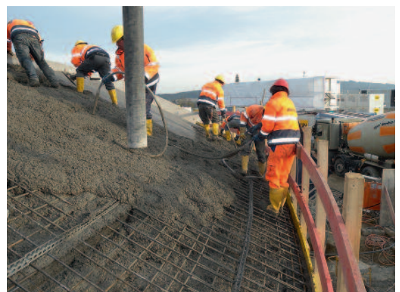
Betonierarbeiten am steil abfallenden Kegeldach des Randbauwerks.
