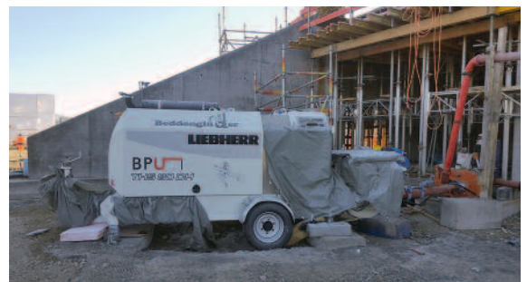
Ein extrastarkes Pumpaggregat war notwendig, um den Beton der Geschossdecken hochzupumpen.
