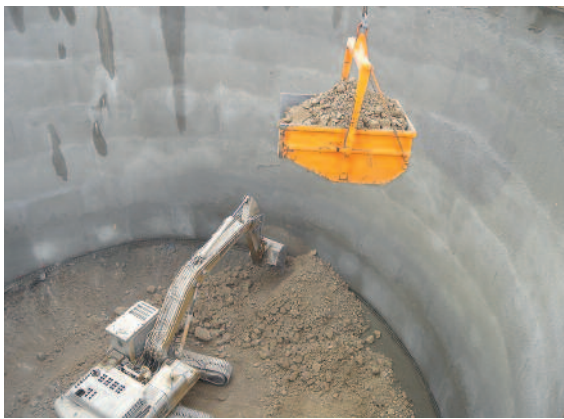
Grabarbeiten am Fundamentschacht.
