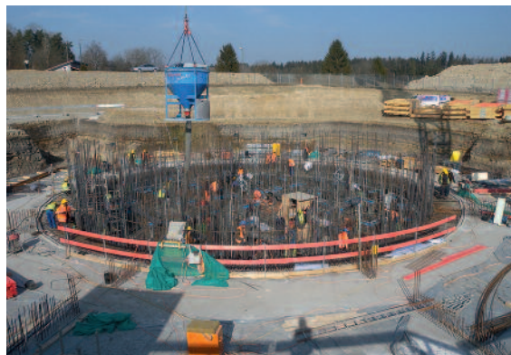
Der erste Gleitabschnitt nähert sich seinem Ende, die ersten 30 Meter des Turms sind gebaut.
