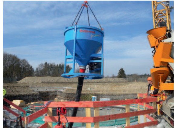
Der Betomat, ein Krankübel des Gleitschalbauers, lässt sich über eine Steuerung am Schlauchende bedienen.
