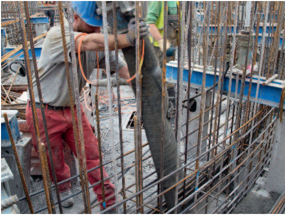
Der Beton kann damit punktgenau und in der richtigen Menge eingebracht werden.
