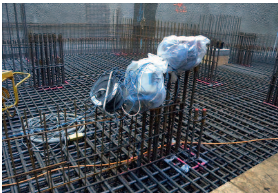
Die Bodenplatte weist nicht nur einen hohen Bewehrungsgrad auf, sie wurde auch mit Sensoren zur Temperaturmessung bestückt.
