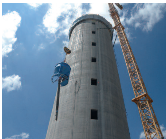
Die mit dem Höhenwachstum immer länger werdenden Hubwege ließen die Krankapazität zu einem kritischen Faktor werden.
