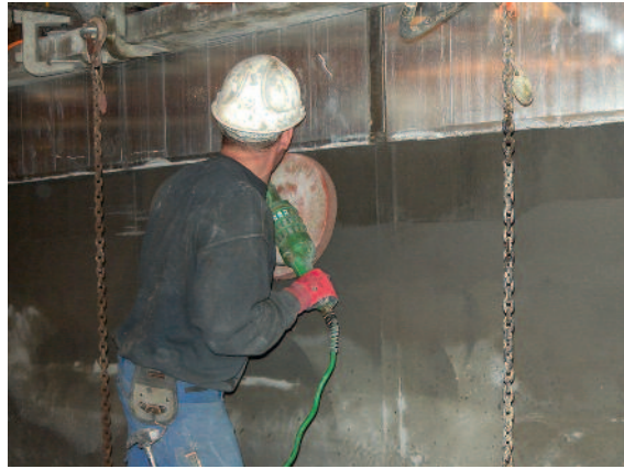
Mit einer rotierenden Schwammscheibe werden unterhalb der hochgeglittenen Schalung die Luftporen des Betons geschlossen.
