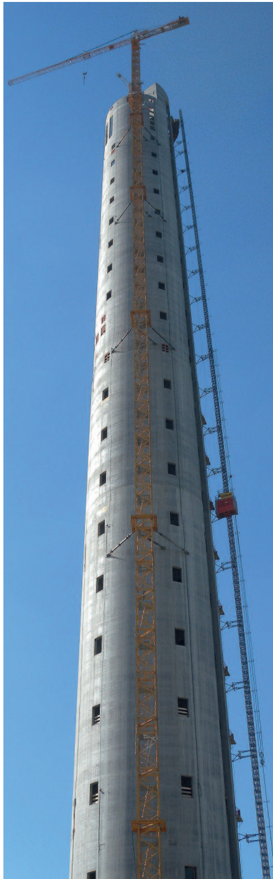
Noch nie entstand ein so hohes Bauwerk in so hohem Tempo mit einer so hohen Betonfestigkeit in der Gleitschalbauweise.
