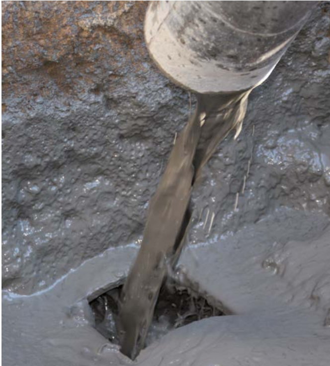
Verfüllung stillgelegte Rohrleitung
